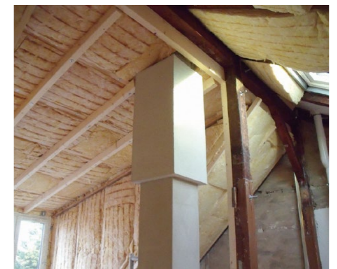
Abbildung 30 Begleitdämmung eines massiven Schornsteinkopfes
