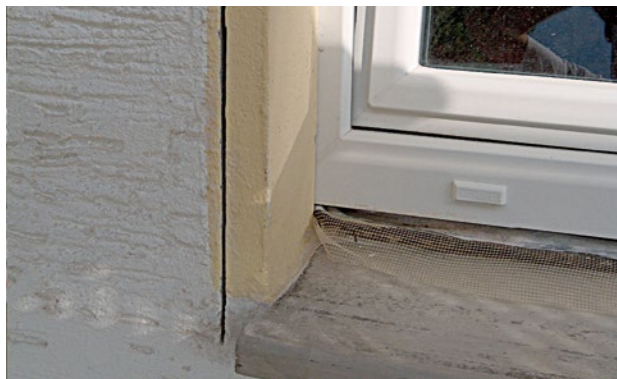
Abbildung 87 Massiver Mauerwerksanschlag wird eingeschnitten und abgebrochen
