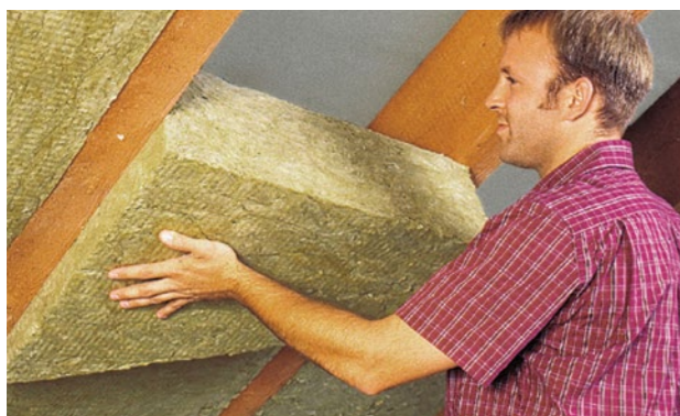
Abbildung 34 Zwischensparrendämmung aus Dämmkeilen
