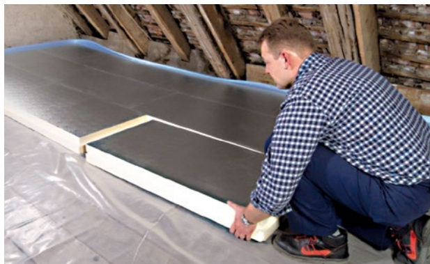
Abbildung 52 Einbau von druckfesten Hartschaumplatten
