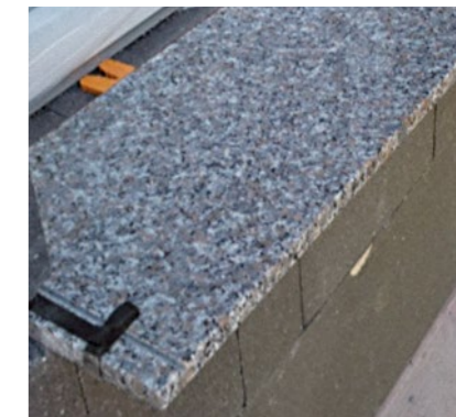
Abbildung 90/91 Fensterbank mit aufgeklebtem Quellband
