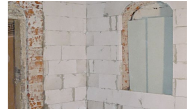
Abbildung 80 Einsatz von Mineralschaumplatten mit Flankendämmung an der einbindenden Innenwand
