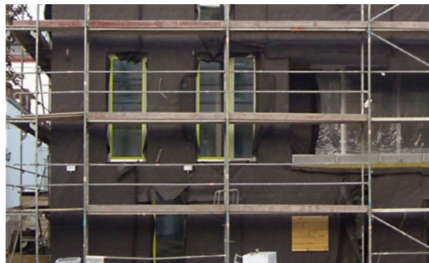
Abbildung 73 Anbringen der diffusionsoffenen Unterspannbahn
