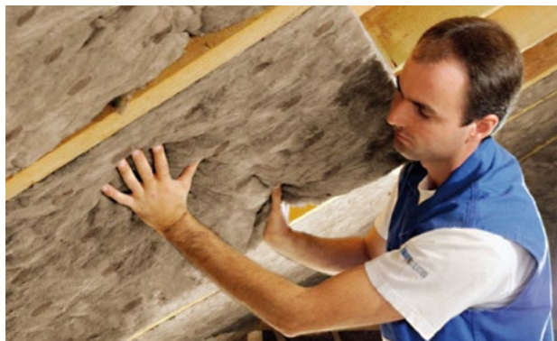
Abbildung 33 Einbau einer Mineralwolldämmung zwischen den Sparren
