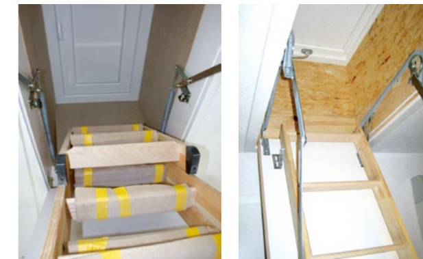
Abbildung 57/58 Neueingebaute Bodentreppen mit zusätzlich gedämmter Bodenklappe
