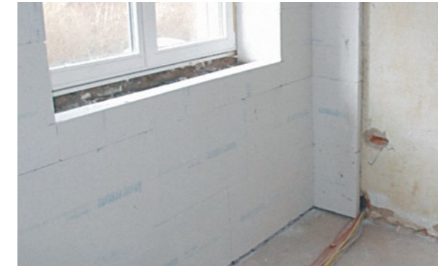
Abbildung 79 Einsatz von Calziumsilikatplatten mit Flankendämmung an der einbindenden Innenwand
