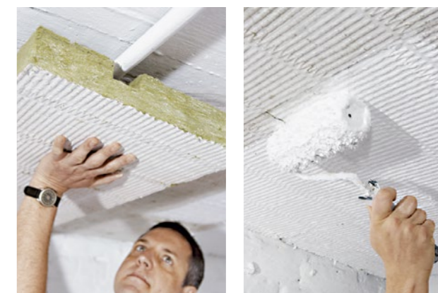
Abbildung 92/93 Anbringen einer mineralischen Unterdeckendämmung
