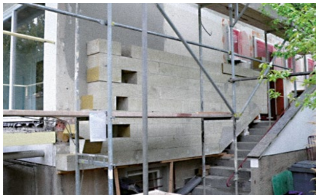
Abbildung 65/66 Anbringen einer starken Außendämmung mit Lamellen aus Mineralwolle
