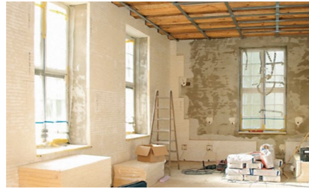
Abbildung 77/78 Vollflächiges Verkleben einer kapillaraktiven Innendämmung
