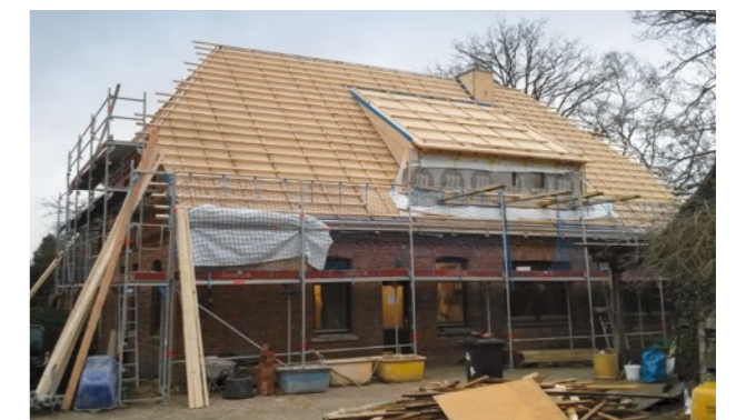
Abbildung 39 Aufsparrendämmung
