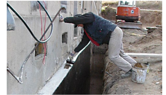
Abbildung 98 Anbringen des Voranstriches für die folgende Bitumendickbeschichtung
