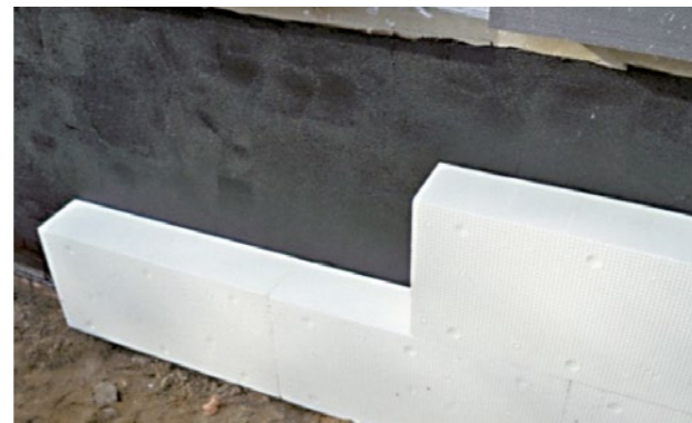
Abbildung 68 Angebrachte Perimeterdämmung im Sockelbereich
