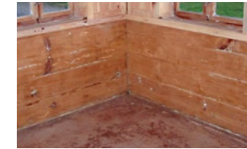
Abbildung 18 Rauminnecke einer Außenwand aus Holz-Blockbohlen
