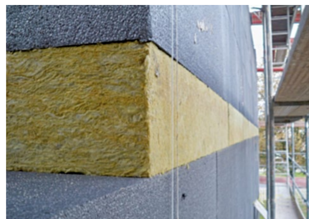
Abbildung 22 Brandriegel aus Mineralwolle
