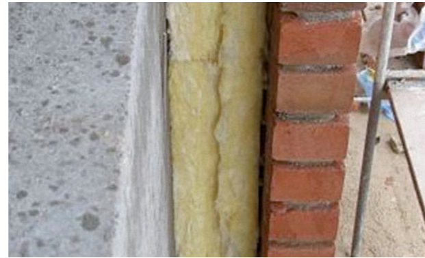
Abbildung 76 Einbau einer Kerndämmung (Neubau)
