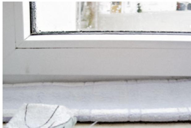
Abbildung 9 Starker Tauwasserausfall am Randverbund des Glases
