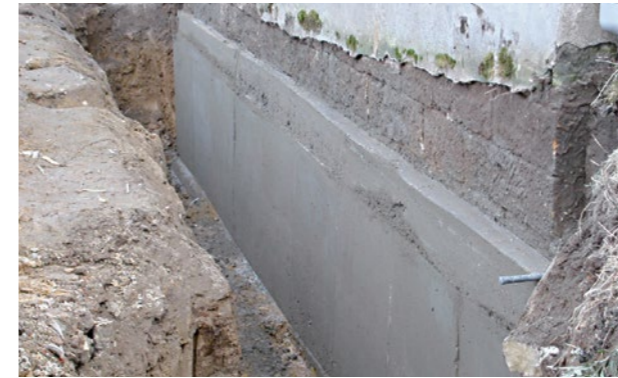
Abbildung 97 Betonierte Vorsatzschale einer Kelleraußenwand
