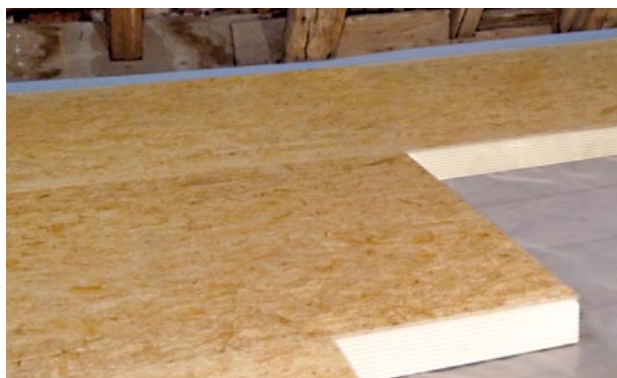
Abbildung 53 Einbau von druckfesten Hartschaumplatten mit OSB-Oberfläche
