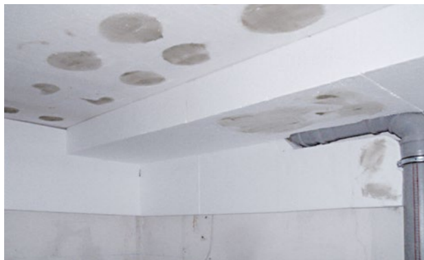
Abbildung 94 Kellerdecken- und Flankendämmung der Innenwand
