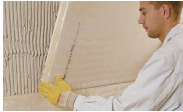
Abbildung 77/78 Vollflächiges Verkleben einer kapillaraktiven Innendämmung
