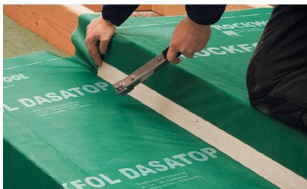
Abbildung 42 Anbringen einer Anpresslatte für den Einbau der Dämmung ohne luftgefüllte Zwischenräume
