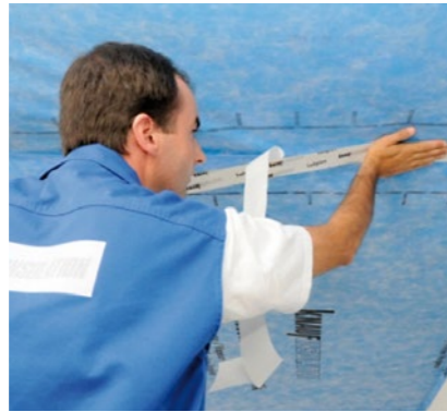
Abbildung 47 Verkleben der Folienstöße mit speziellem Klebeband
