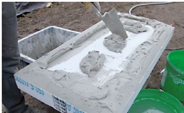
Abbildung 67 Verklebung einer Sockeldämmplatte im Wulst-Punkt-Verfahren
