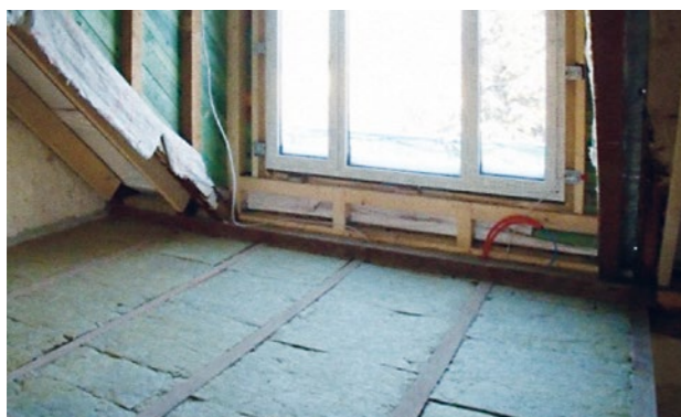
Abbildung 55 Zwischensparrendämmung mit Mineralwolle
