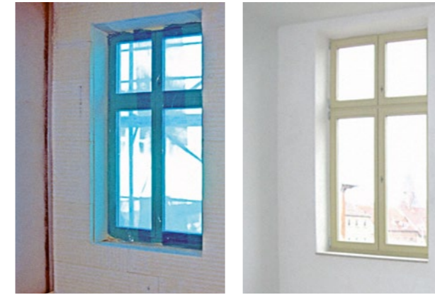
Abbildung 81/82 Einsatz eines Innenwand-Dämmsystems unter Einbeziehung der Fensterlaibungen
