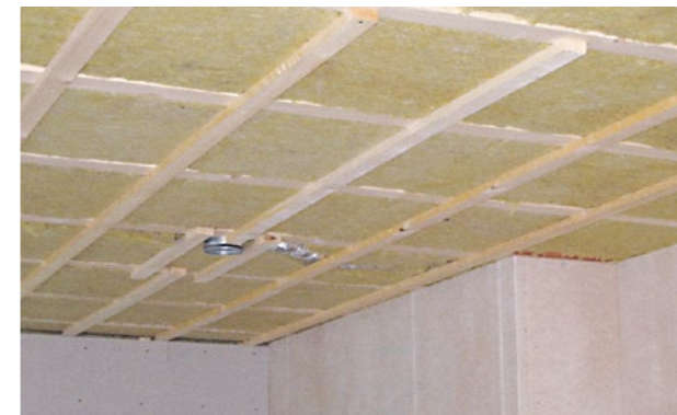
Abbildung 56 Einbau einer Unterdeckendämmung aus Mineralwolle
