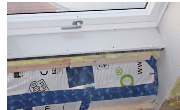
Abbildung 44 Anschluss Dampfbremse an Dachfenster
