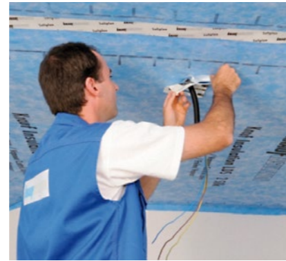
Abbildung 48 Verkleben einer Kabeldurchführung mit Kabel-Manschette
