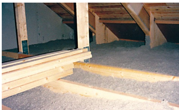
Abbildung 54 Dämmung der obersten Geschossdecke mit Zellulose-Einblasdämmung
