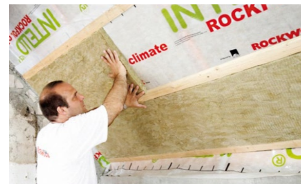
Abbildung 38 Einbau einer Untersparrendämmung zwischen die Konterlattung
