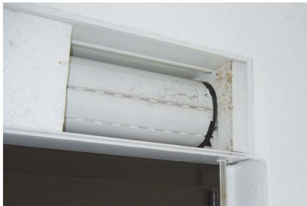
Abbildung 8 Rolladen ungedämmt
