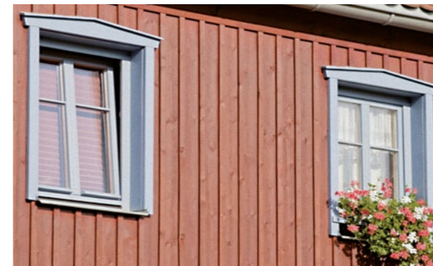
Abbildung 74 Rekonstruktion einer landestypischen Holzverschalung
