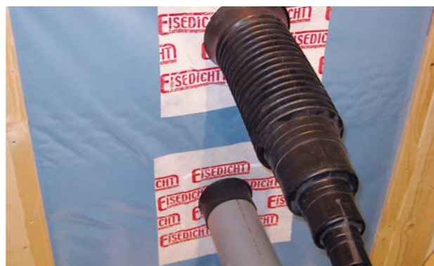
Abbildung 50 Verwendung von Luftdichtungsmanschetten für verschiedene Rohrdurchführungen
