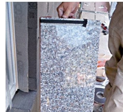
Abbildung 90/91 Fensterbank mit aufgeklebtem Quellband
