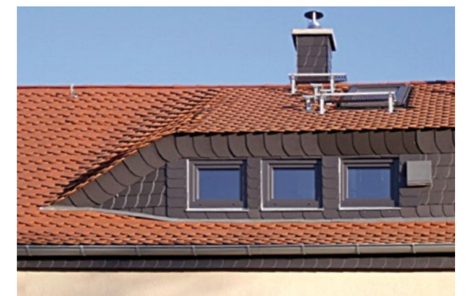
Abbildung 25 Saniertes Dach mit Dachgaube
