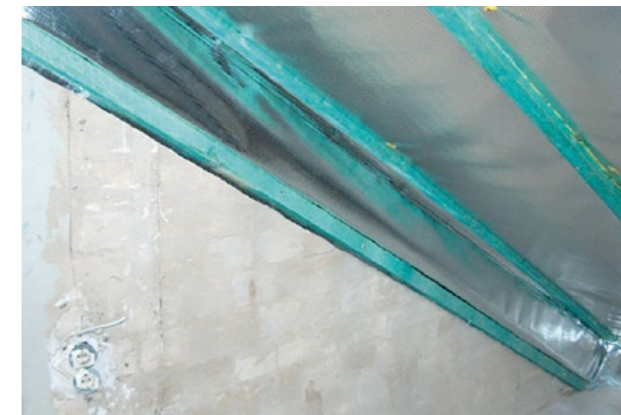
Abbildung 28/29 Möglichkeit einer Flankendämmung mit Mineraldämmplatten
