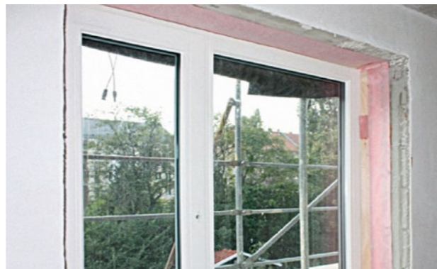
Abbildung 88 Einbau eines neuen Fensters mit Dichtklebeband
