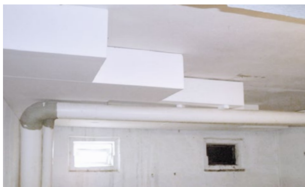
Abbildung 95 Verkleidung der Decke mit 20 cm starken Dämmplatten
