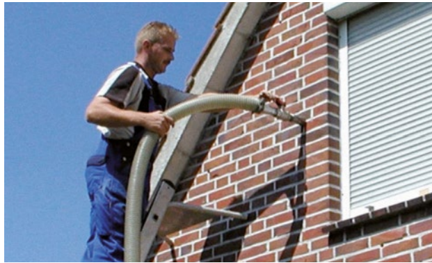
Abbildung 75 Einbringen einer Einblasdämmung (Bestand)
