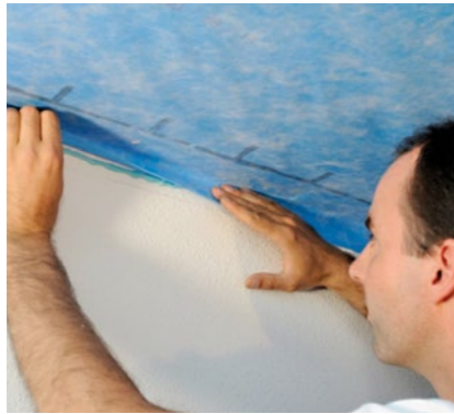
Abbildung 46 Andrücken der Dampfbremsefolie auf die Klebewulst
