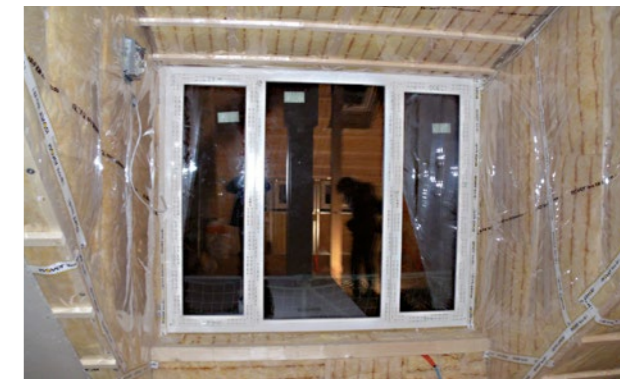
Abbildung 43 Dachgaube mit umlaufend angeschlossener Dampfbremse
