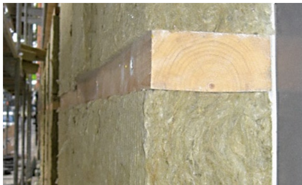
Abbildung 72 Wärmeschicht zwischen der Holzunterkonstruktion
